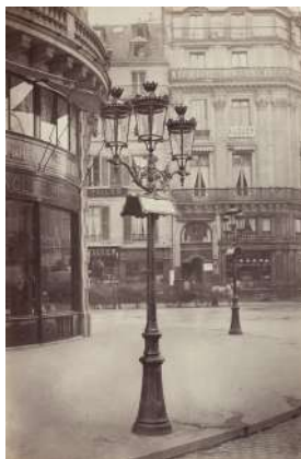
20 Νέα φωτιστικά δρόμου
