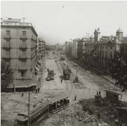
39 Νέο σιδηροδρομικό δίκτυο
